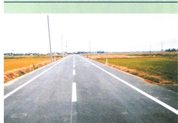
8 <施工地>下福岡地内 <年度>H17~H25 <事業費>13.7億円
