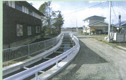
3 <施工地>島田集落周辺 <年度>H9~H26 <事業費>15.3億円
