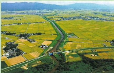
1 <施工地>安野川下流部 <年度>H10~H23 <事業費>210.8億円
