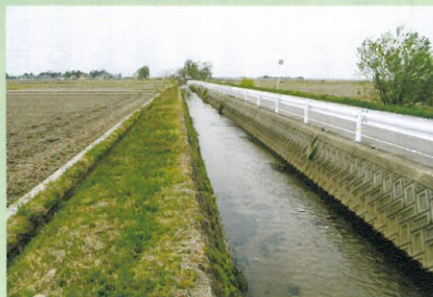
6 <施工地>塚田集落付近 <年度>H21~H31 <事業費>8.1億円
