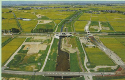
2 <施工地>月崎周辺 <年度>H14~H26 <事業費>37.9億円
